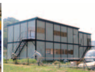
建設中の仮設園舎
