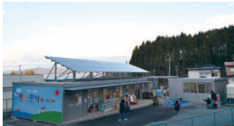
完成した仮設園舎
