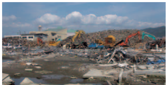
被災後の写真(写真提供:気仙沼市)
