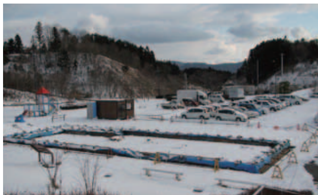
志津川保健センターの建設地
